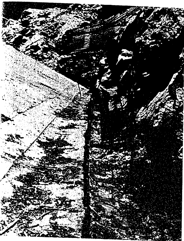
Foto 1.—Junta abierta entre los dos hormigones del plinto; corresponde a la zona «B» de la figura 2.
