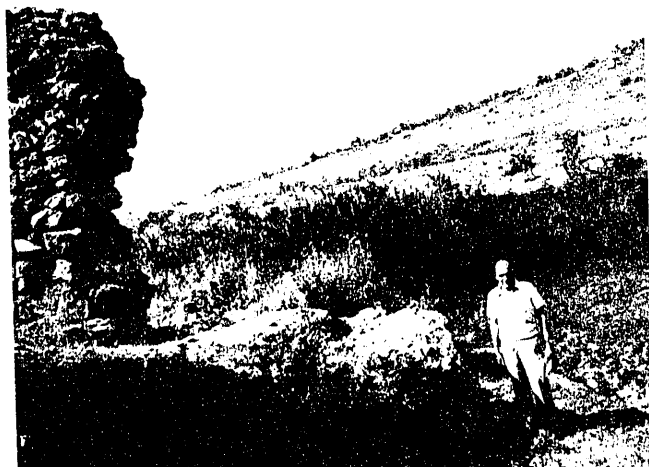
Fig. 2.—Cauce del río Amarguillo y extremo conservado de la presa.
