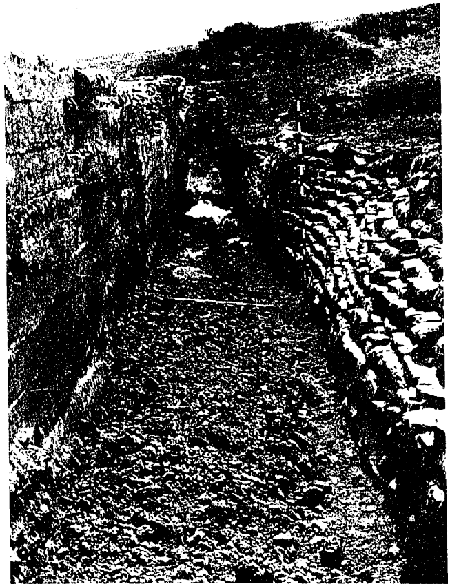
Fig. 6.—Presa de Iturranduz. Paramento de aguas arriba y muro paralelo.
