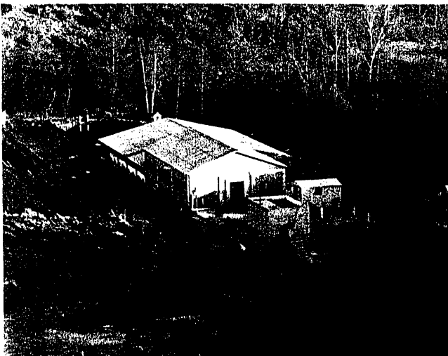
Vista general de las instalaciones para la producción de alevines.
