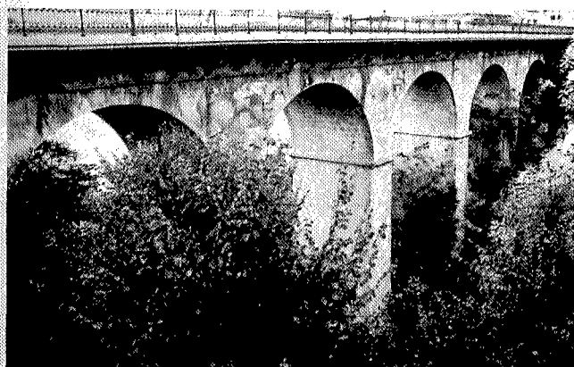
Alcoy. — Puente de la «Pechina». Obra contemporánea y del mismo autor que el de San Roque. Es el único puente alicantino del siglo XIX del que existe constancia de que se cimentó con pilotes. Cinco vanos de medio punto de 11,50 m y una altura de rasante de casi 30 m.
