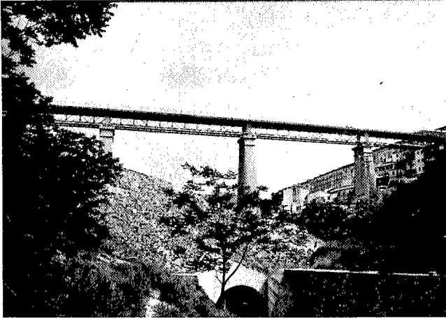
Alcoy.—Viaducto de Canalejas. La mejor obra de su proyectista Próspero Lafarga, ingeniero muy querido en Alicante. Era un tablero de viga en celosía de 45° doble con cuatro luces, dos de 44 m. y dos de 36 m. Fue inaugurado en 1907. A finales de 1985 el tablero fue dignamente sustituido por otro metálico proyectado por el equipo de Juan Batanero.
