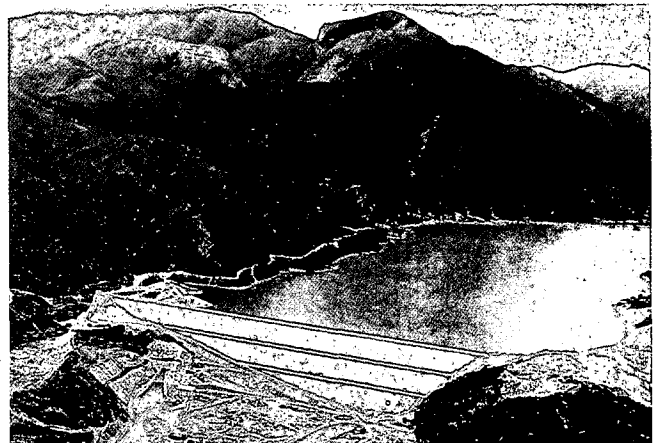
Presa de Sabaneta (República Dominicana).
