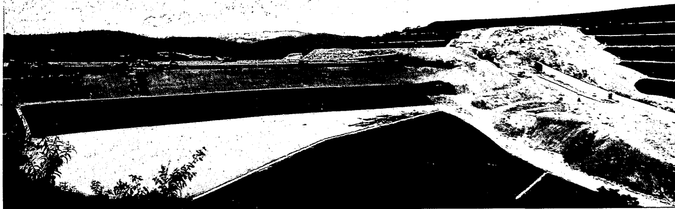
Presa de Río Grande (Colombia).
