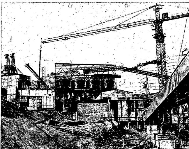
Foto 7.—Instalaciones de refrigeración de áridos y producción de hielo.
