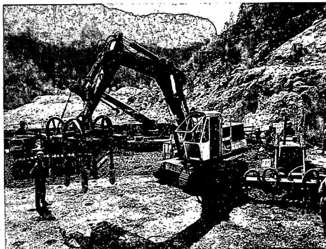
Foto 9.—Equipo tipo de vibración del hormigonado.
