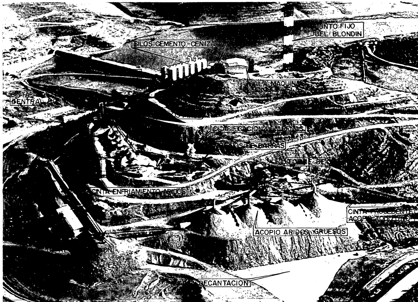
Foto 10.—Instalaciones para el hormigonado de la presa.
