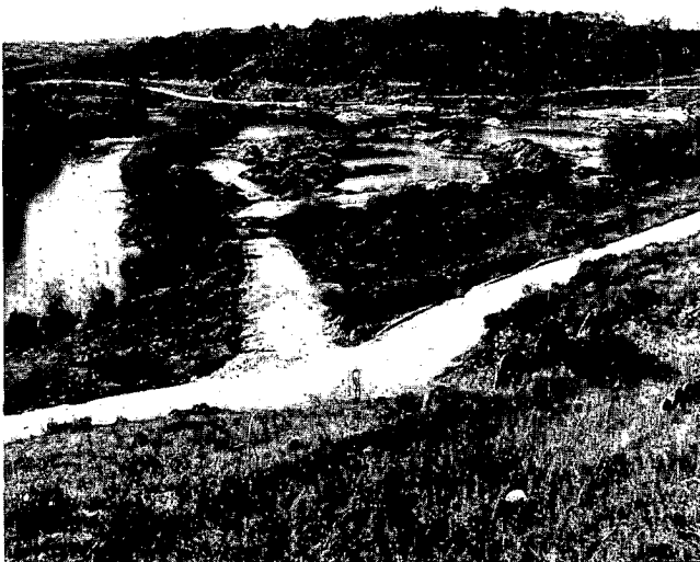
Foto 1.—Vista de una gravera y pista de acceso.
