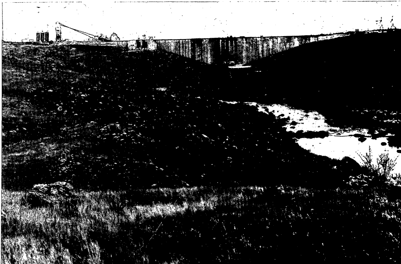
Foto 4.—Vista parcial del vaso después de la deforestación.
