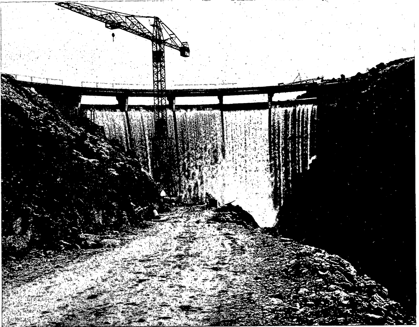
Fig. 2.11.—Presa de los Angeles de San Rafael. Vista desde aguas abajo.
