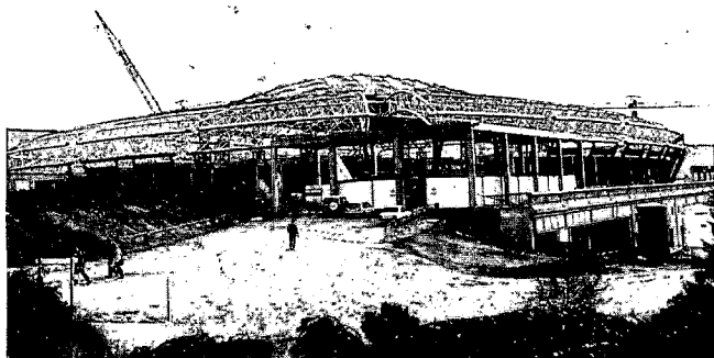
Estado de la cubierta con diez módulos por torre.
