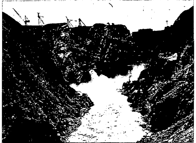
Foto 11.—Presa de Longyangxia. Vista desde aguas abajo: a la derecha el cuerpo central de la presa, y en el centro la Excavación del Aliviadero.
