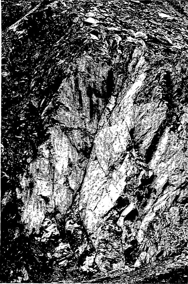
Figura 23.—Deslizamiento en forma de cuña en una cantera de esquistos en La Massana (Andorra).
