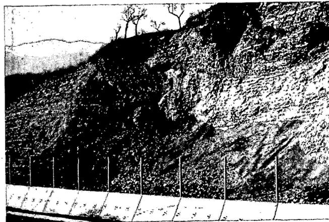
Figura 8.—Aspecto del desmonte (enero de 1986) una vez retirados los materiales derrumbados y saneado el talud.
