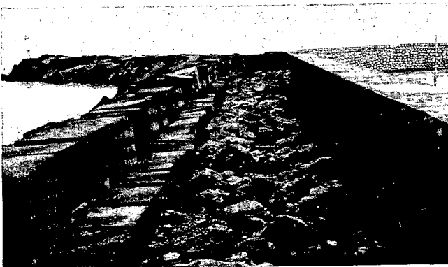
Fig. 21.—Dique con cuenco amortiguador en el puerto de Fuen-girola (Málaga).
