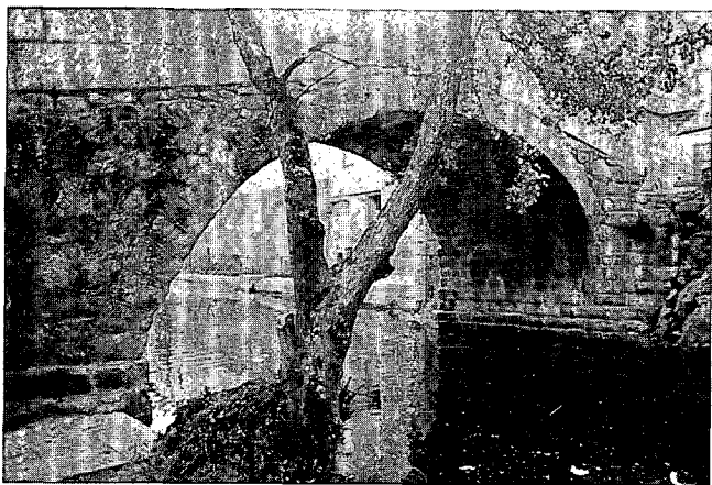
Figura 10. El puente de Baños de Molgas.
