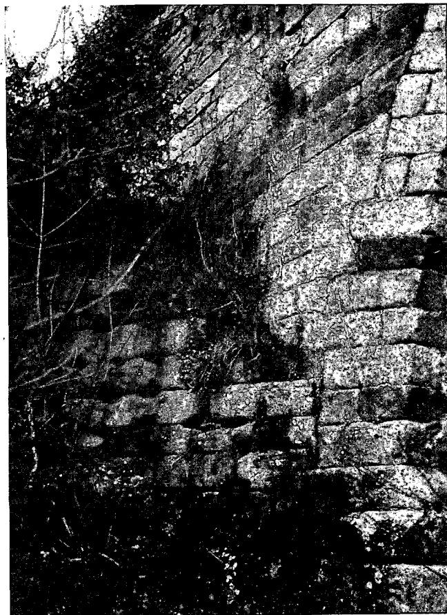
Figura 12. Sillares romanos en los estribos bajo el puente medieval de Ponte Navea.
