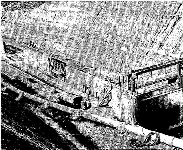
Foto 10. Hormigonado de cajero intermedio al canal y al aliviadero en la zona de aguas abajo.
