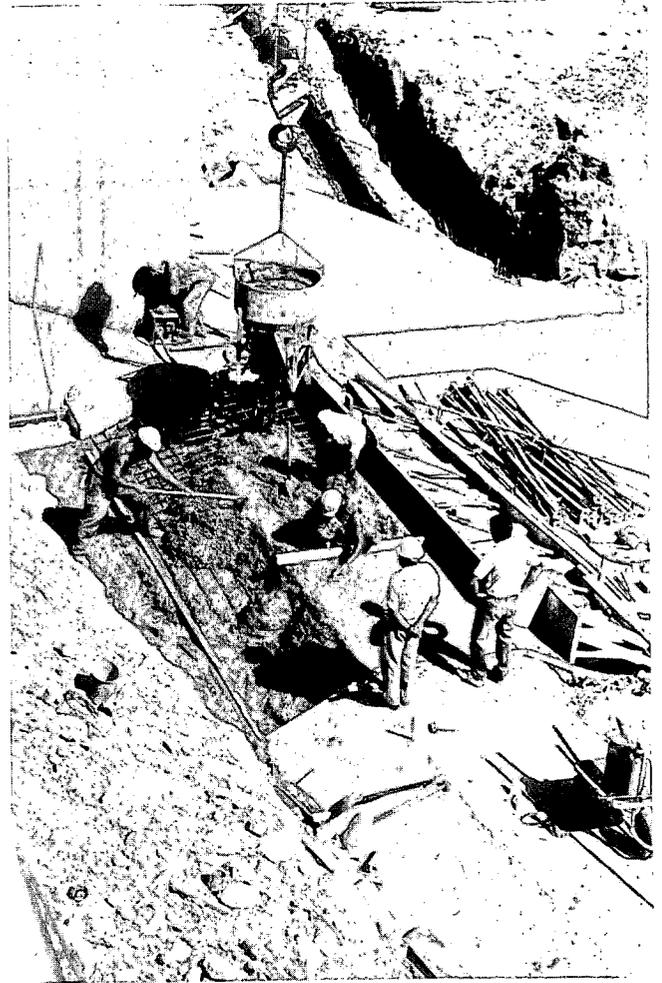
Foto 11. Hormigonado de la viga de atado en cabeza de pantalla en margen izquierda. Al fondo vista de la pantalla tras el descabezado en la margen derecha.
