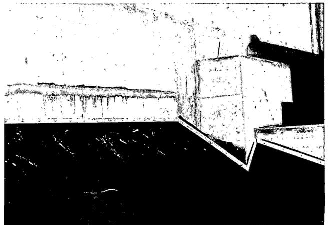
Foto 12. Vista de la lámina de impermeabilización y de su unión al hormigón de la presa.
