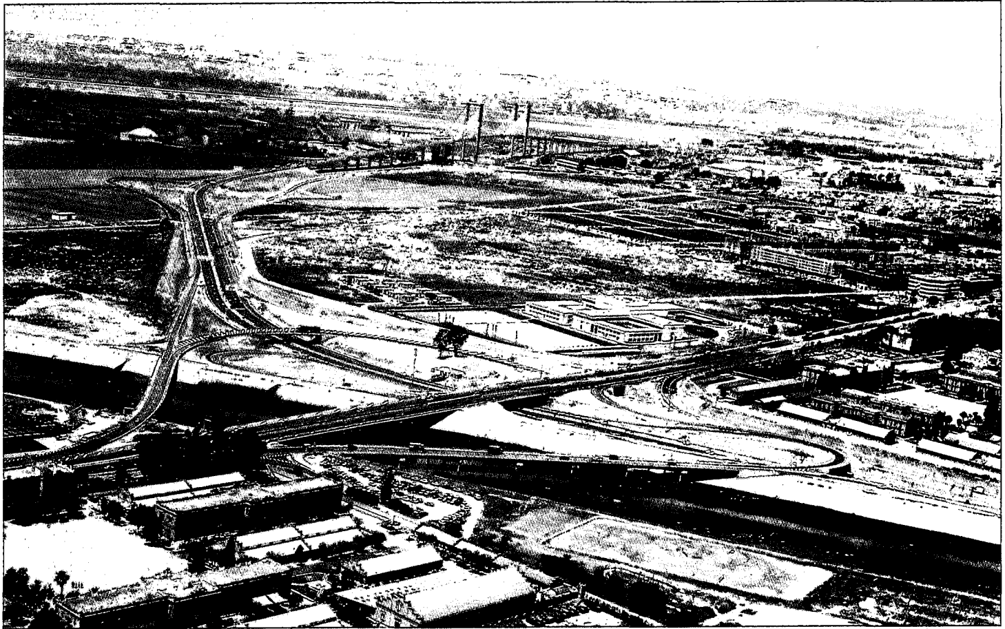
Tramo suroeste de la autovía de circulación con Enlace de acceso a Cádiz y Puente del Centenario. Tablada y El Aljarafe al fondo.
