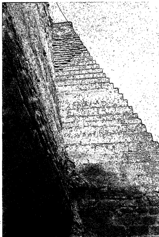
Figura 5. Detalle del paramento de aguas arriba
