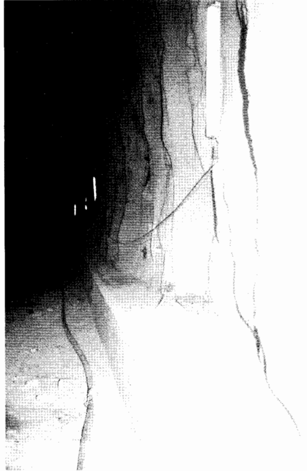
Figura 20. Ejemplo de dos secciones del túnel con el sostenimiento colocado y el revestimiento en ejecución. Izquierda: sección excavada con un perfil próximo al teórico. Derecha: sección excavada con una importante sobre-excavación. (8 de junio de 1992).
