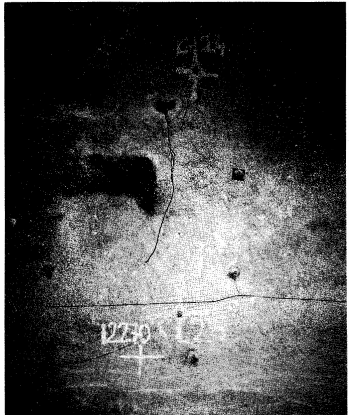
Figura 11. Registro para las medidas de convergencias en los túneles de «El Padrún».
