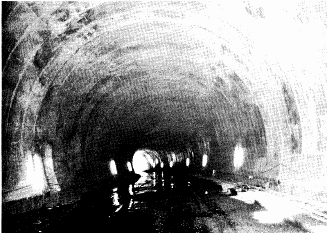
Figura 20. Ejemplo de dos secciones del túnel con el sostenimiento colocado y el revestimiento en ejecución. Izquierda: sección excavada con un perfil próximo al teórico. Derecha: sección excavada con una importante sobre-excavación. (8 de junio de 1992).
