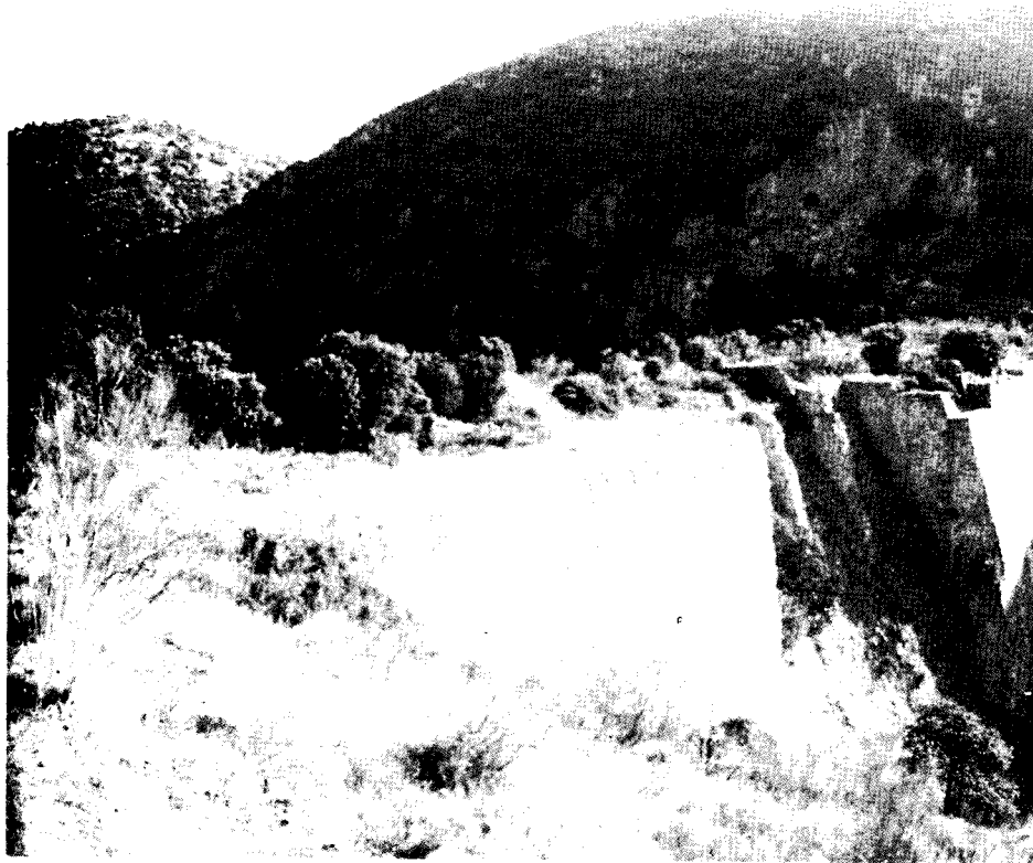
Presa de Gasco.
