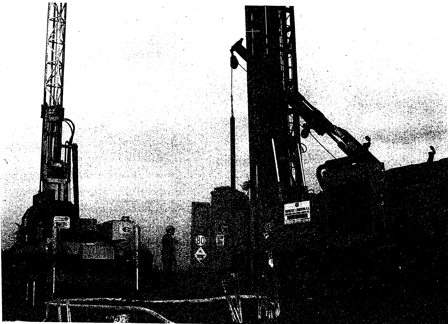
Figura 4. El equipo perforador con martillo en fondo está a la derecha; el de jet grouting se sitúa a la izquierda. Cada uno se halla en plena actuación simultánea.
