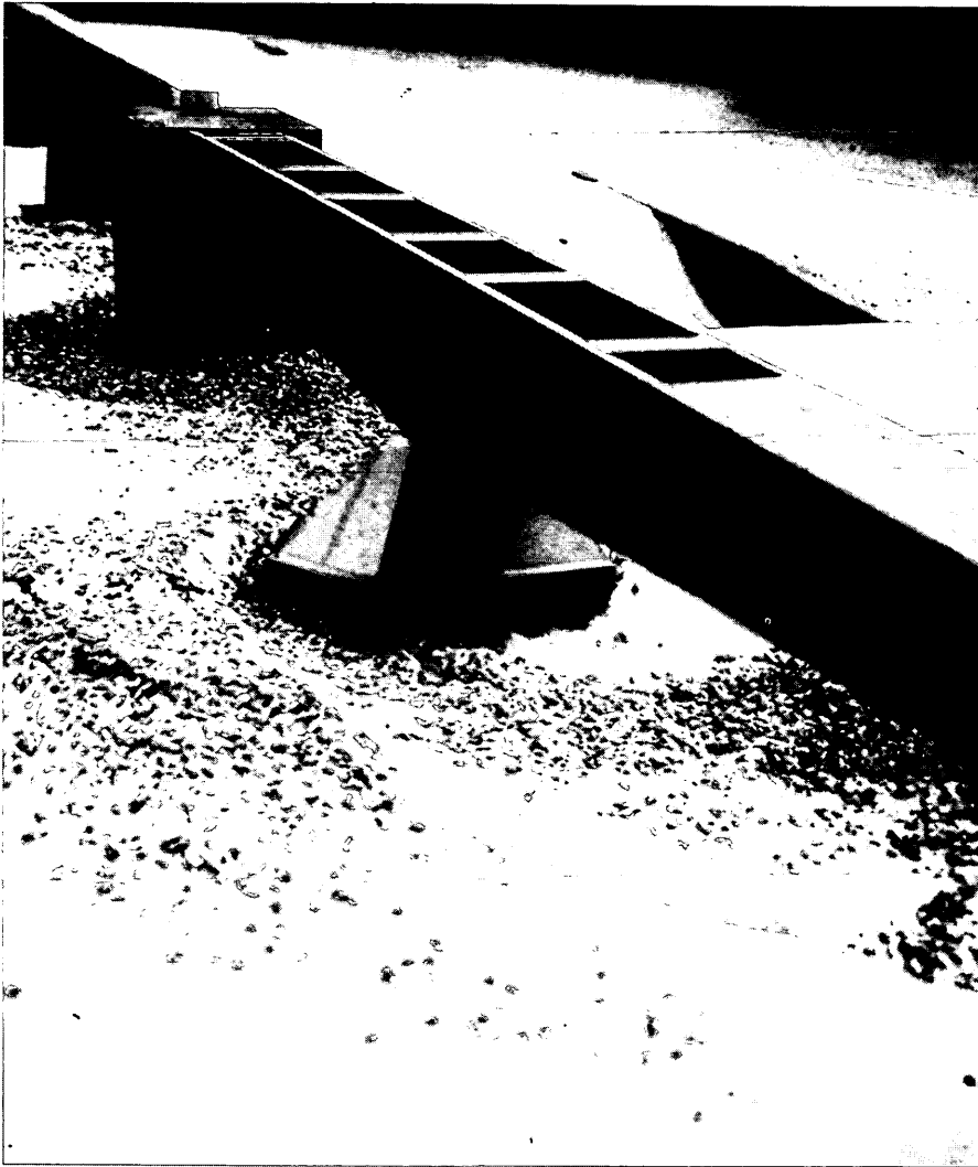
Figura 6. Foto del resultado del primer ensayo de protección, constituida por piedra demasiado pequeña. La protección de la pila izquierda quedó desmantelada.
