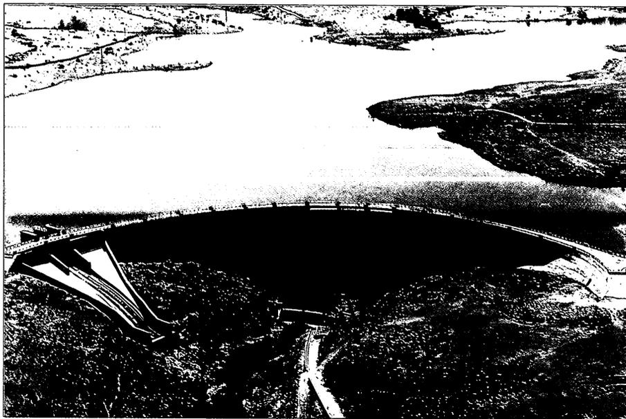
La Presa del Pontón Alto, situada sobre el río Eresma, es una bóveda de 48 m de altura que crea un embalse de 80 Has de superficie y 7,4 Hm<sup>3</sup> de capacidad.
