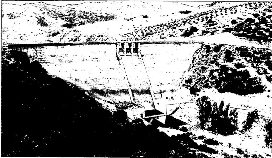
La presa de la Puebla de Cazalla está situada sobre el río Corbones, afluente del Guadalquivir por la margen izquierda, en la provincia de Sevilla. Su función es la regulación del río Corbones, la laminación de sus avenidas, permitir la puesta en regadío de 3.424 Has., en los términos municipa-
