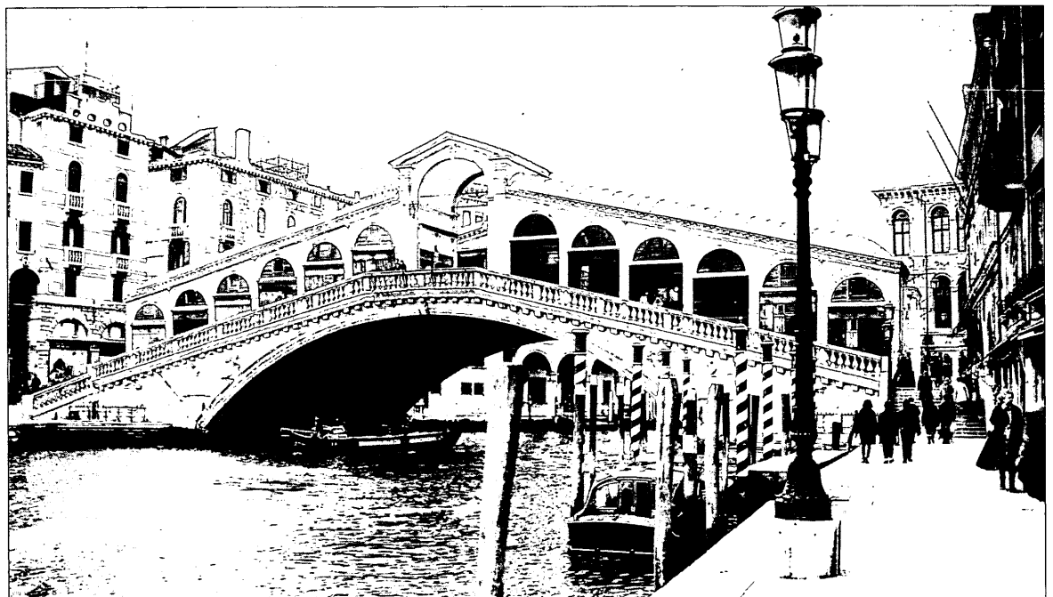
Puente de Rialto en Venecia. Siglo XVI.
