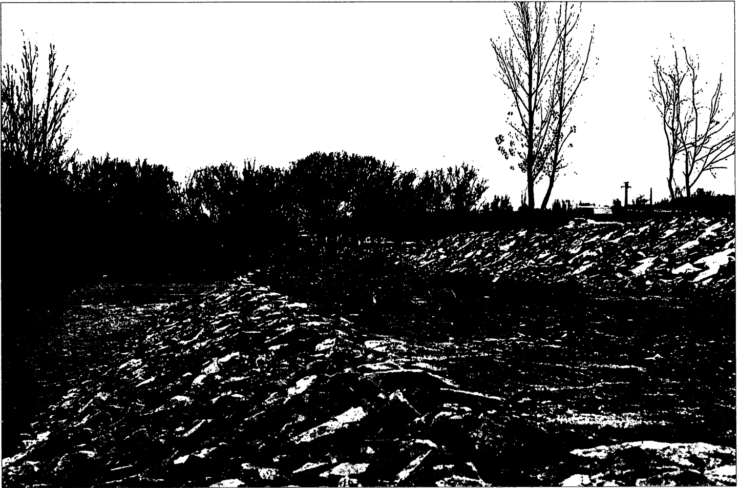
Fotografía 10. Actuación puntual en el río Guadarrama. Protección de margen con dos niveles.
