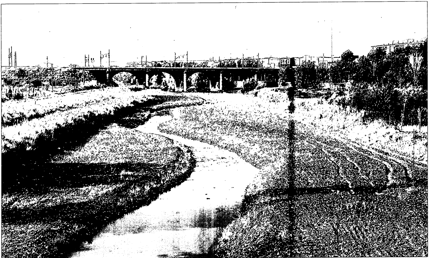
Fotografía 3. Cauce adicional en la margen izquierda del río Jarama, con sección de aguas bajas y de avenidas.
