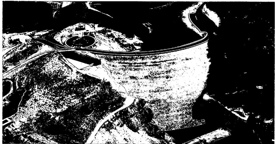
arriba como aguas abajo. El núcleo conecta con una pantalla plástica de bentonita cemento, dispuesta al efecto de proteger fundamentalmente frente al sifonamiento. El volumen de espaldones es de 1.100.000 m<sup>3</sup> y el del núcleo de 338.000 m<sup>3</sup>.
