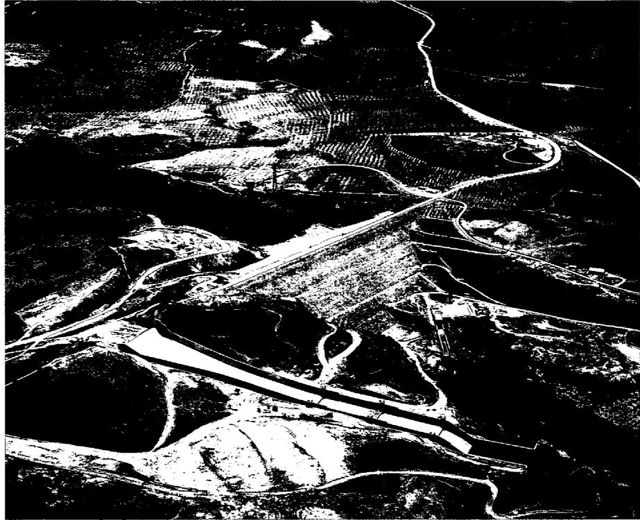
tud de 600 m y una anchura de 40 m; su capacidad de desagüe para el espejo de agua situado a nivel de coronación es de 6.279 m<sup>3</sup>/s. El embalse cuenta, en su zona media, con otro aliviadero de superficie situado en el denominado collado de la Esperilla; consta de un vertedero de labio fijo, de planta recta y una longitud de 200 m a la cota
