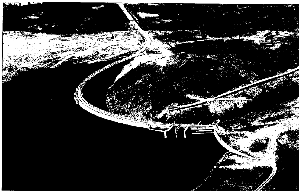
PRESA DEL PONTÓN ALTO EN T.M. DE PALAZUELOS DE ERESMA (SEGOVIA)
