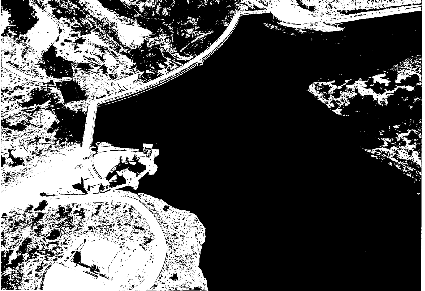
Foto 4. Presa de Puentes. Vista general del antiguo embalse de Puentes. En el estribo izquierdo se puede ver la embocadura del "Morning Glory".
