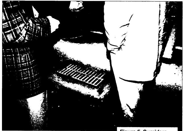
Figura 5. Sumidero en el túnel de Vallvidrera en construcción. (14 de junio de 1991).
