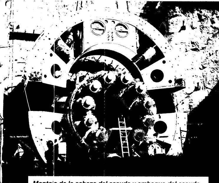
Montaje de la cabeza del escudo y emboque del escudo desde el pozo de ataque.
