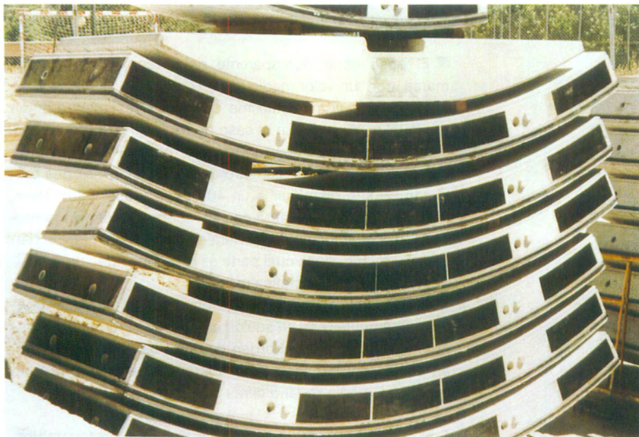
Figura 7. Dovelas del Anillo "Madrid" y pieza auxiliar para la vía de trenes de obra.
