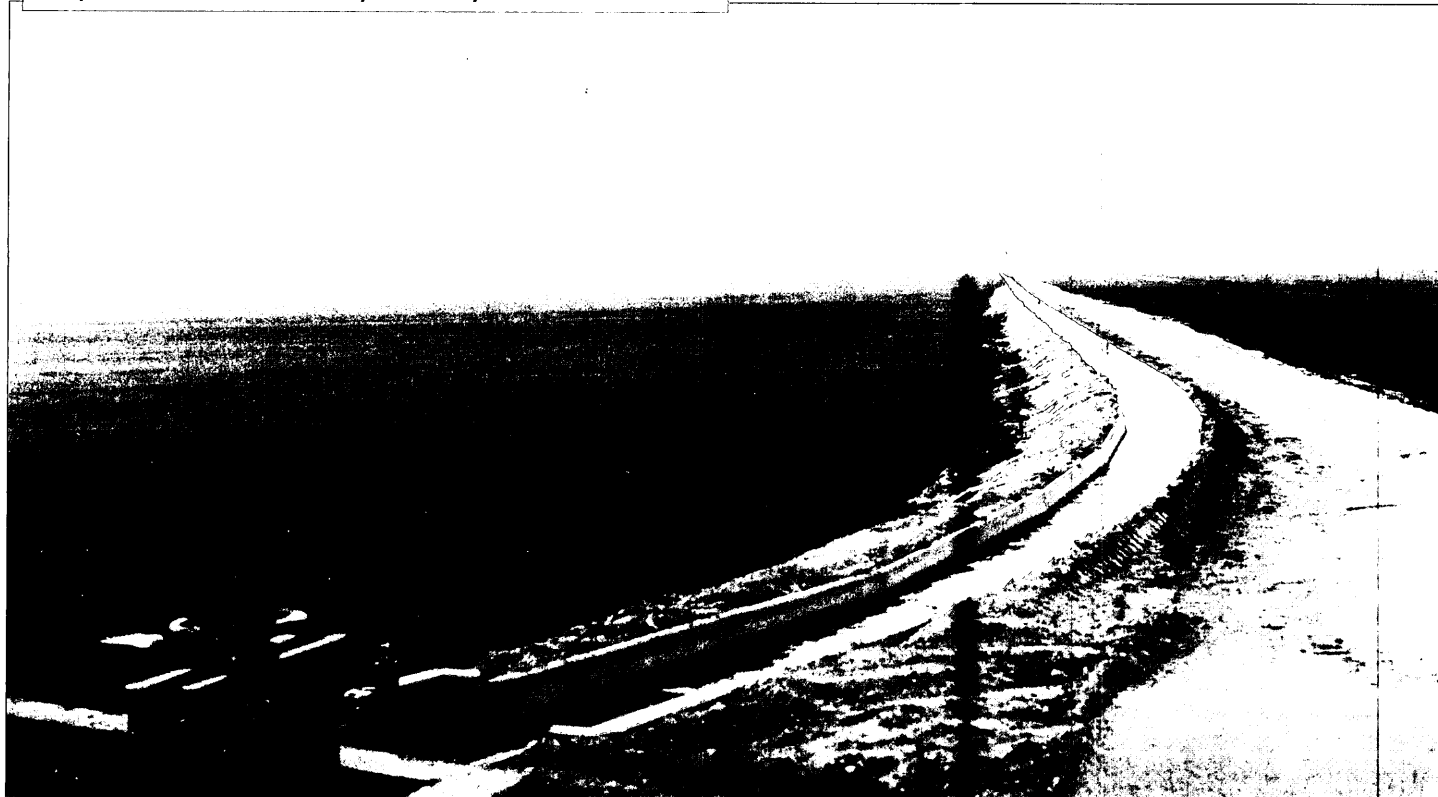
Acequia secundaria del Delta izquierdo después del revestimiento.
