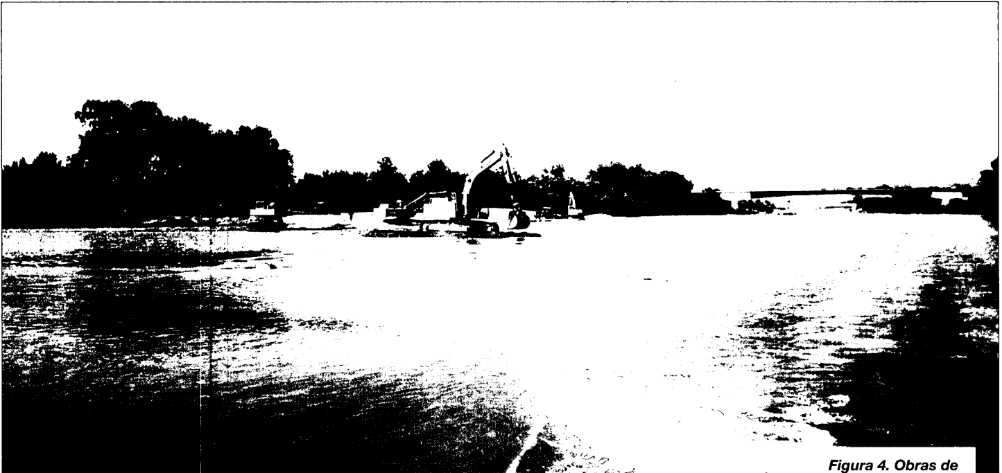
Figura 4. Obras de dragado en el Ebro aguas abajo de Tortosa.
