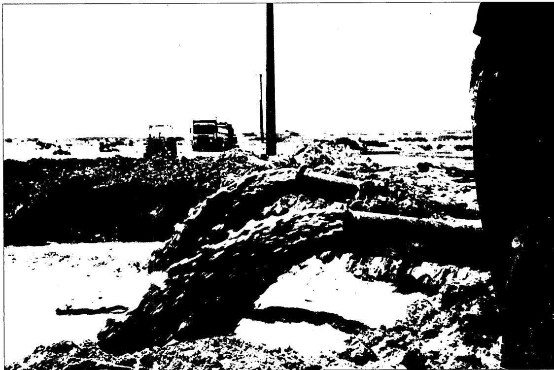
Figura 3. Detalle trabajos ejecución duna.
