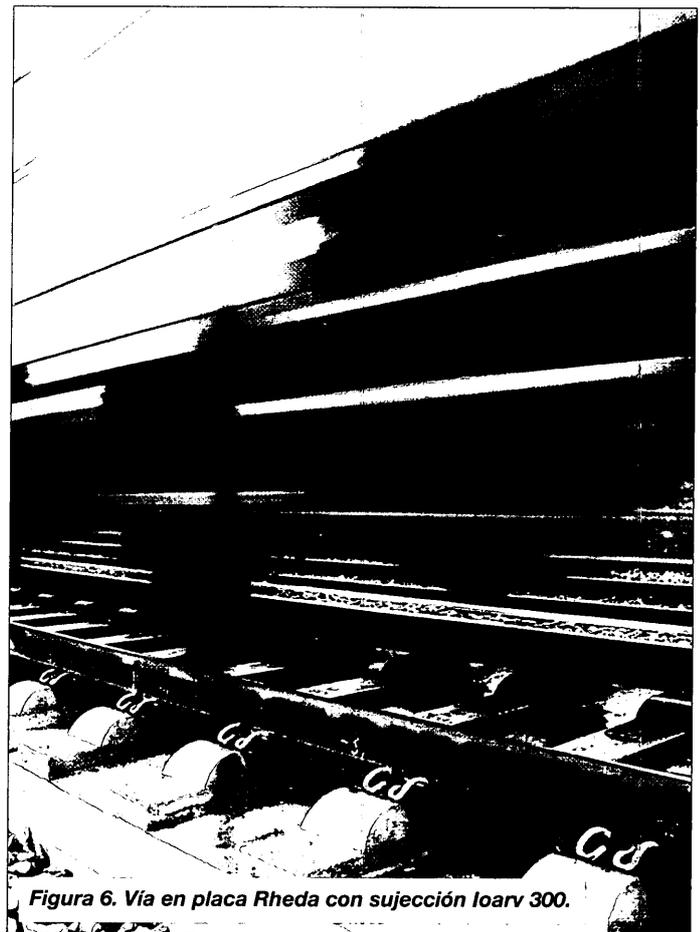
Figura 6. Vía en placa Rheda con sujeción ioarv 300.
