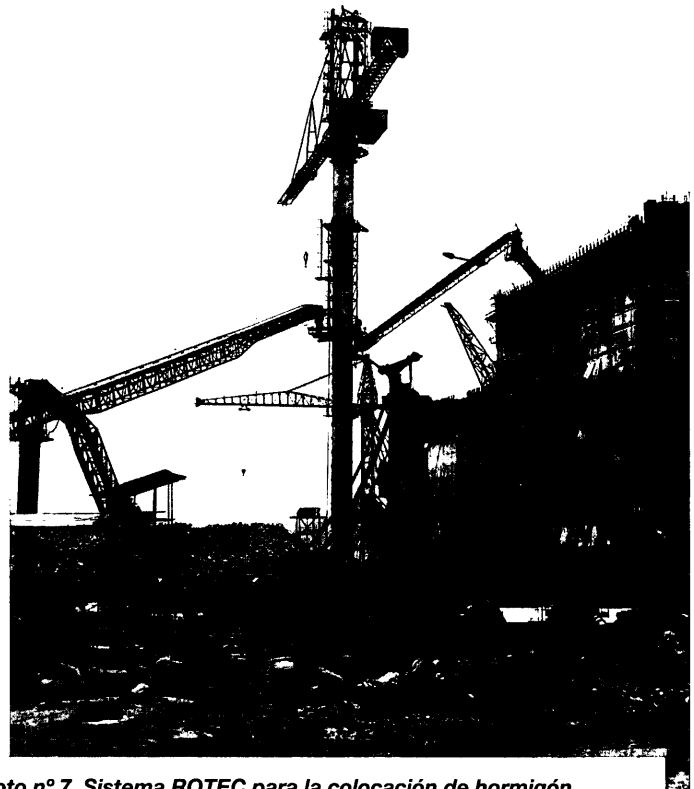
Foto nº 7. Sistema ROTEC para la colocación de hormigón.
