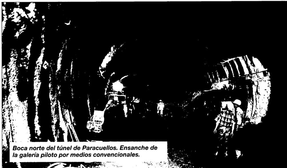
Boca norte del túnel de Paracuellos. Ensanche de la galería piloto por medios convencionales.
