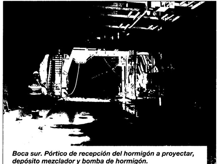
*Boca sur. Pórtico de recepción del hormigón a proyectar, depósito mezclador y bomba de hormigón.*
