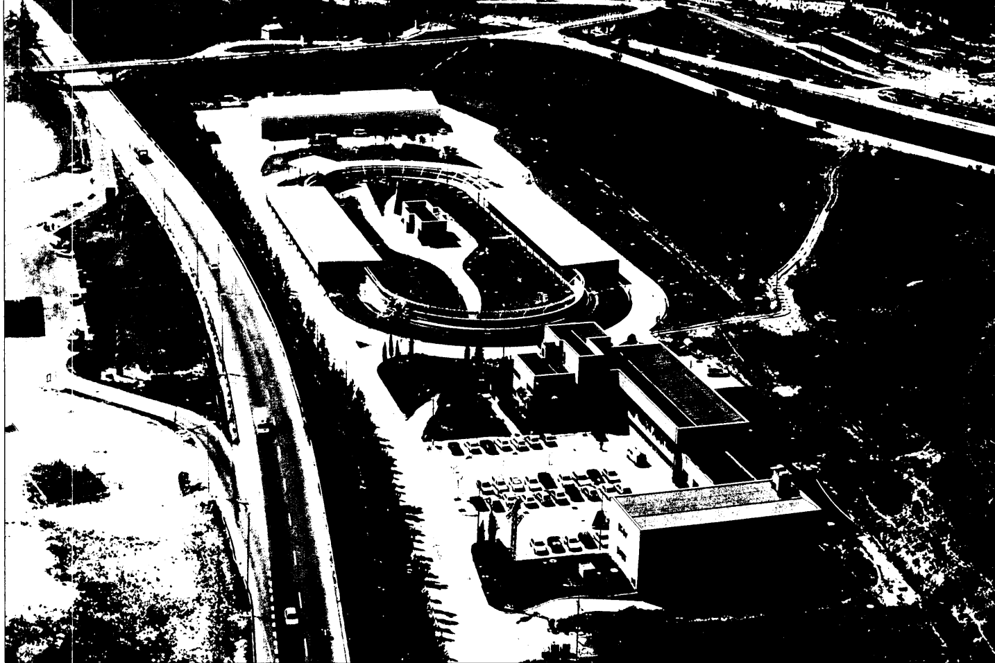
Vista general del Centro de Estudios de Carreteras del CEDEX con la Pista para Ensayos de Firmes a escala real.
