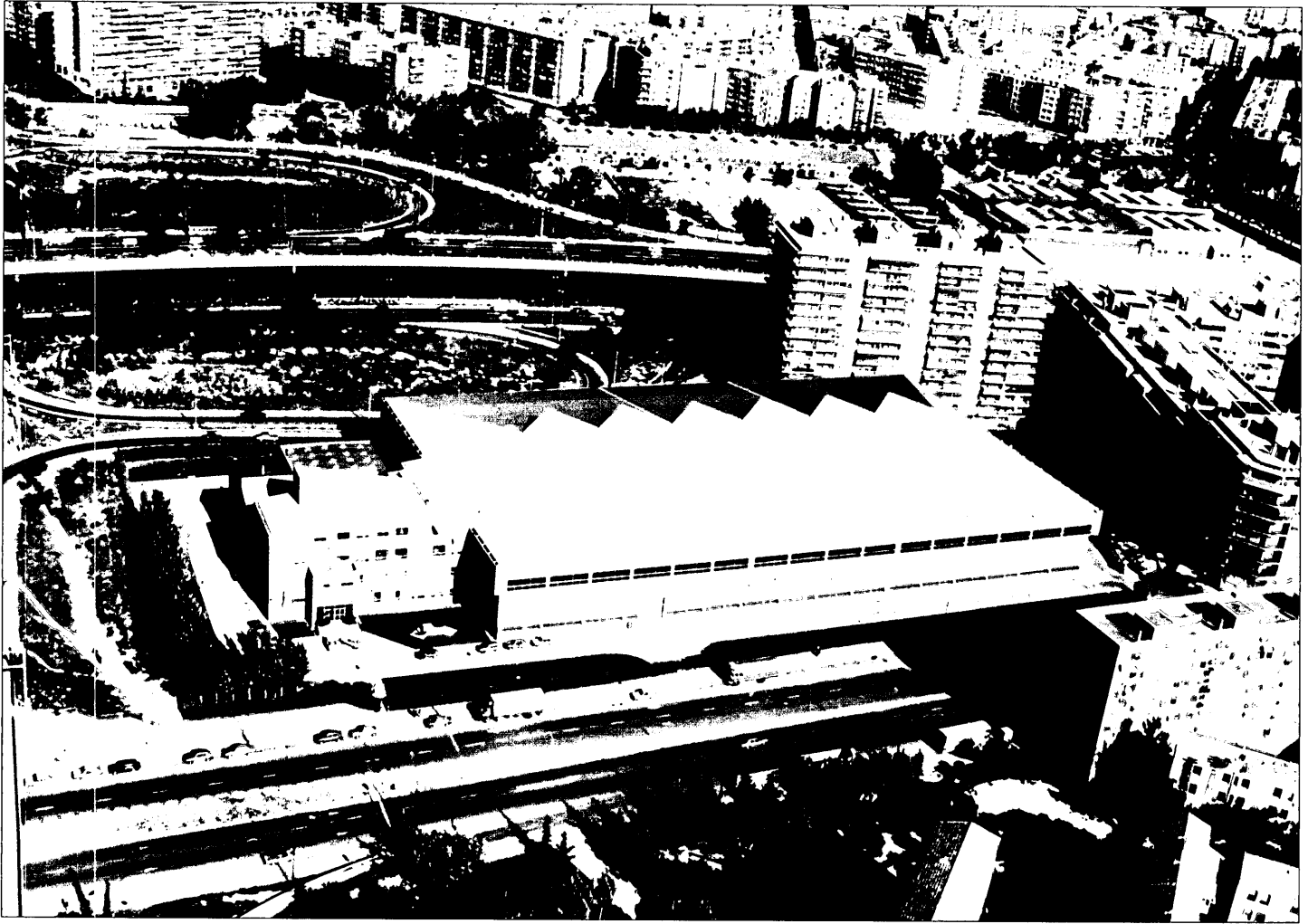
Vista general del Centro de Estudios de Puertos y Costas del CEDEX.
