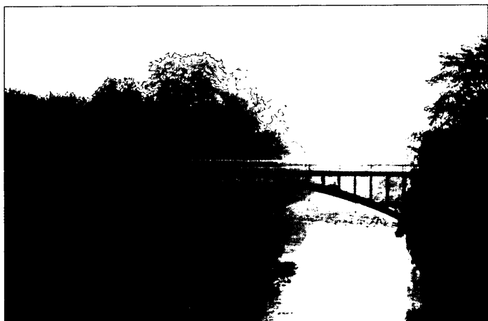
Figura 6: Puente de Golbaro sobre el río Saja, próximo a Torrelavega (Cantabria). Ingeniero José Eugenio Ribera, 1903.
