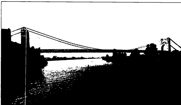
Figura 4: Puesto colgante de Amposta sobre el río Ebro. Ingeniero José Eugenio Ribera, 1914.
