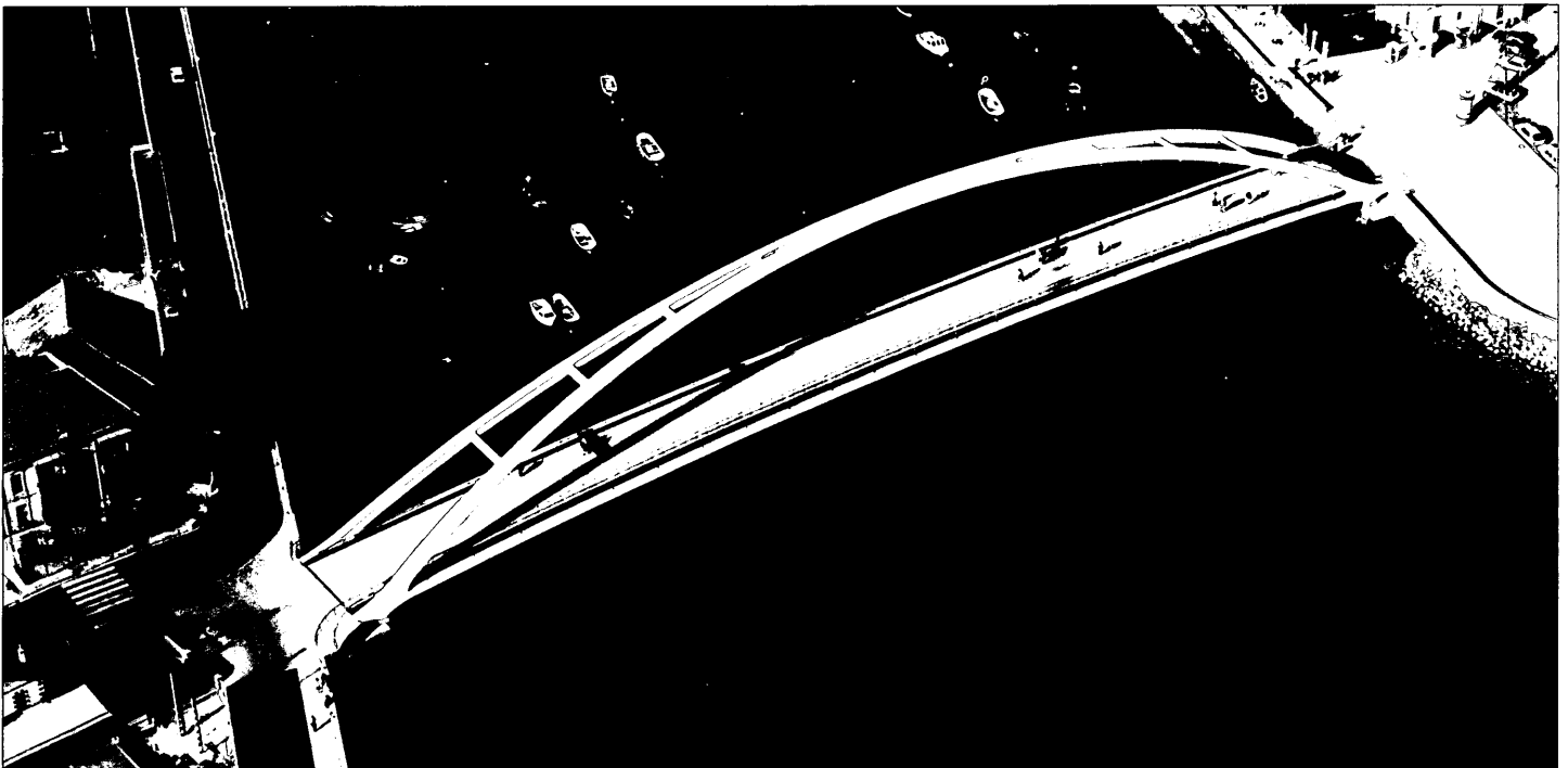
Fig. 15: Pasarela de Plencia, Vizcaya. Ingenieros: Manterola y Fdez Troyano,
