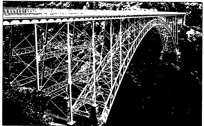
Figura 3: Viaducto de El Pino sobre el río Duero, en Zamora, luz: 120 metros; altura sobre el río: 90 metros. Ing. Ribera, 1914.
