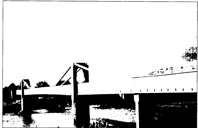
Figura 9: Puente acueducto sobre el río Guadalete, en Tempul (Cádiz). Ingeniero E. Torroja, 1926.
