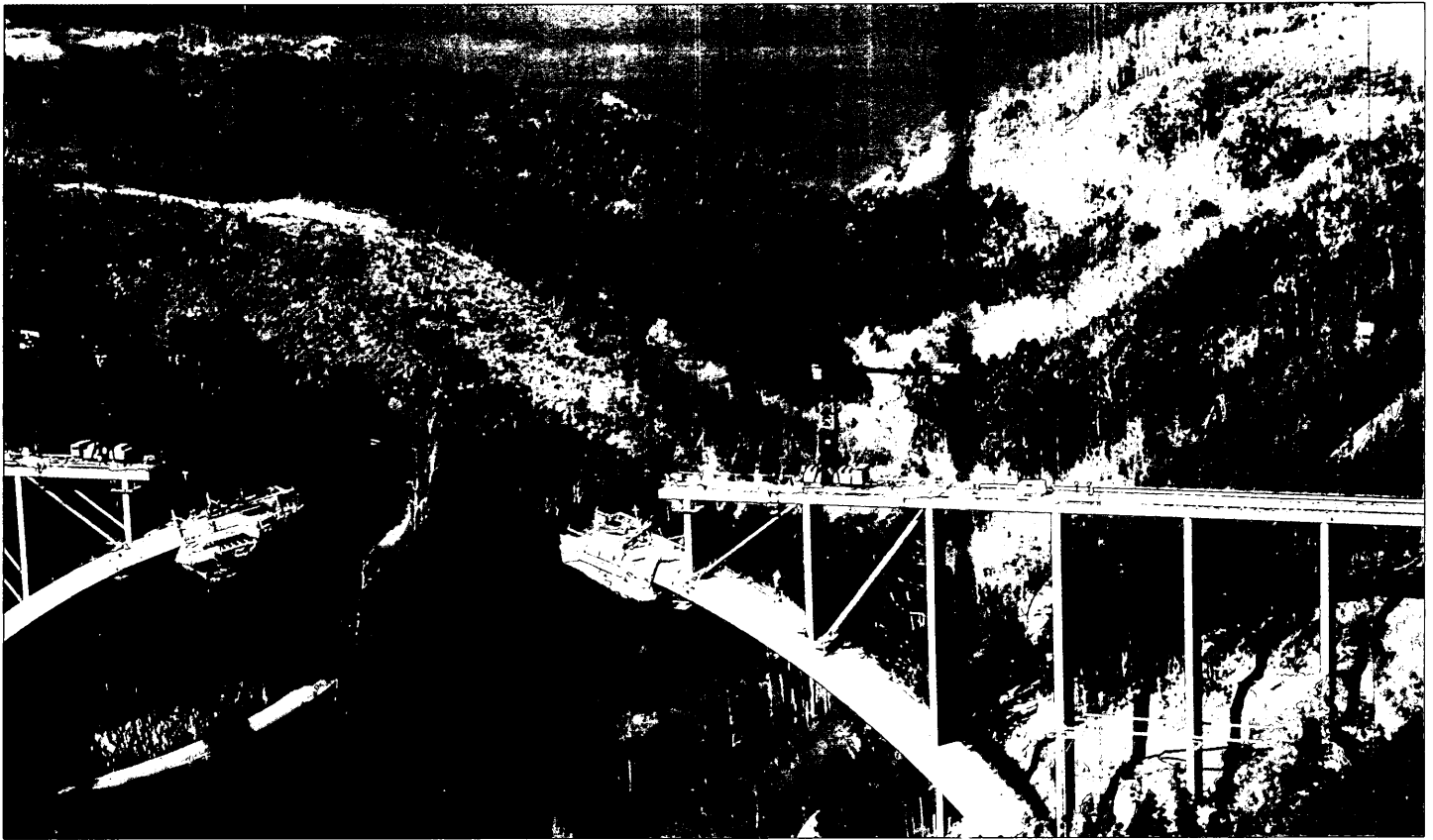
Figura 14: Puente de la Regenta en el Occidente de Asturias. Ingenieros: García Arango, Arenas y Pantaleón, 1996, Constructor: Ferrovial.
