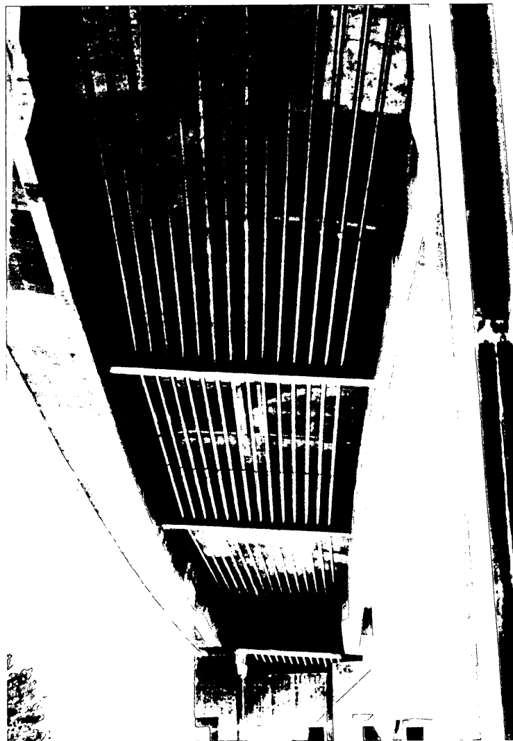
Foto 4. Viaducto en el Eje Transversal de Cataluña/ Viaduct on the Cross-Catalonia Route.
