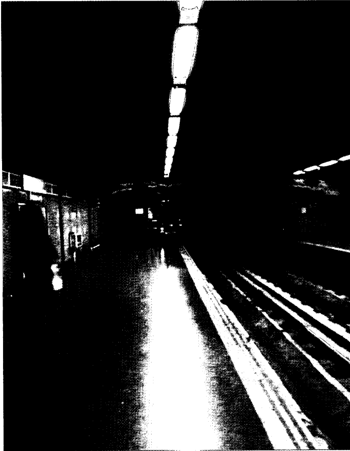
La estación de Buenos Aires conjuntamente con la de Guzmán el Bueno en línea 7 son las dos últimas que se han construido en caverna en el Metro de Madrid.
