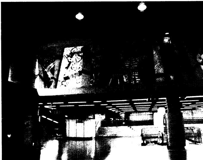
La estación de Miguel Hernández es la primera multiuso de la red de Metro. No solo es uno de los primeros exponentes de la construcción con pantallas y utilización de nuevos materiales de revestimiento sino que además aloja un aparcamiento para 900 vehículos (la entrada se puede ver en el centro de la foto) y una cochera de cuatro vías para ocho trenes.
