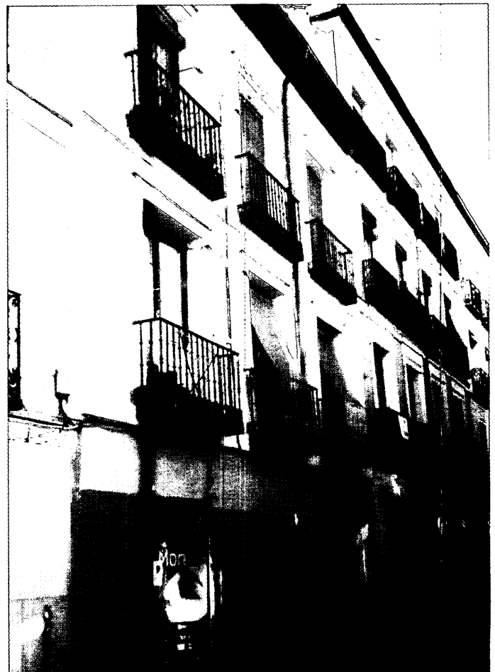
Foto Nº 1. Edificio en Estación de Tribunal.
