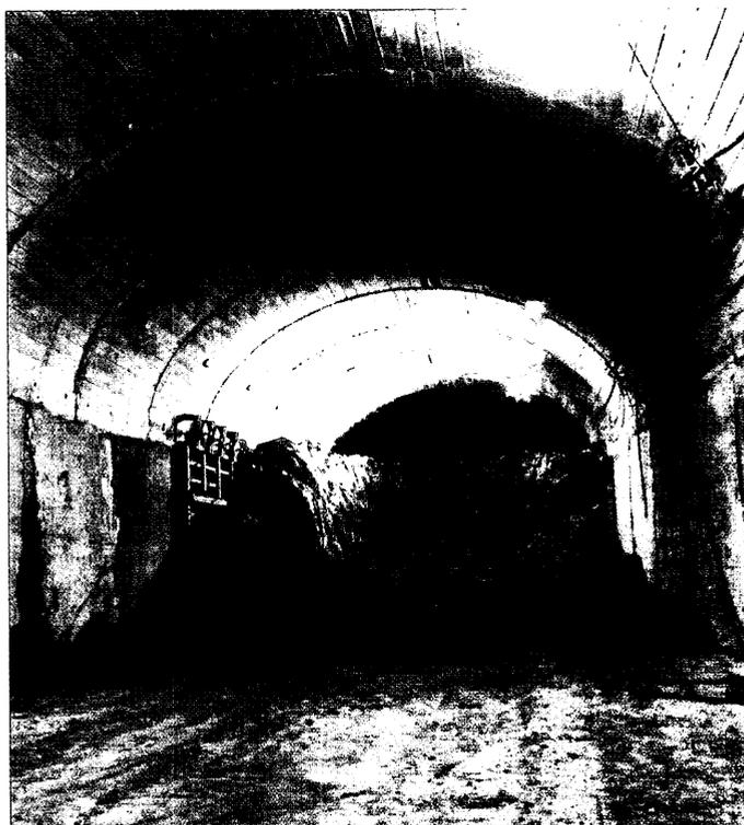
Ejecución de hastiales y destroza de túnel.
