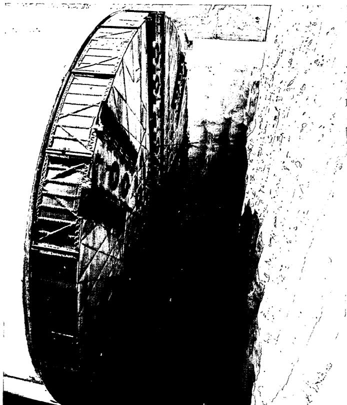
Montaje de la cabeza de corte. Abajo, montaje del back up.
