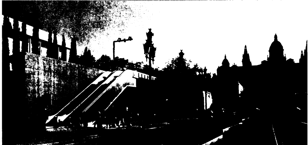
Figura 11. Pasarelas de Montjuïc realizadas con hormigones de alta resistencia [24].
