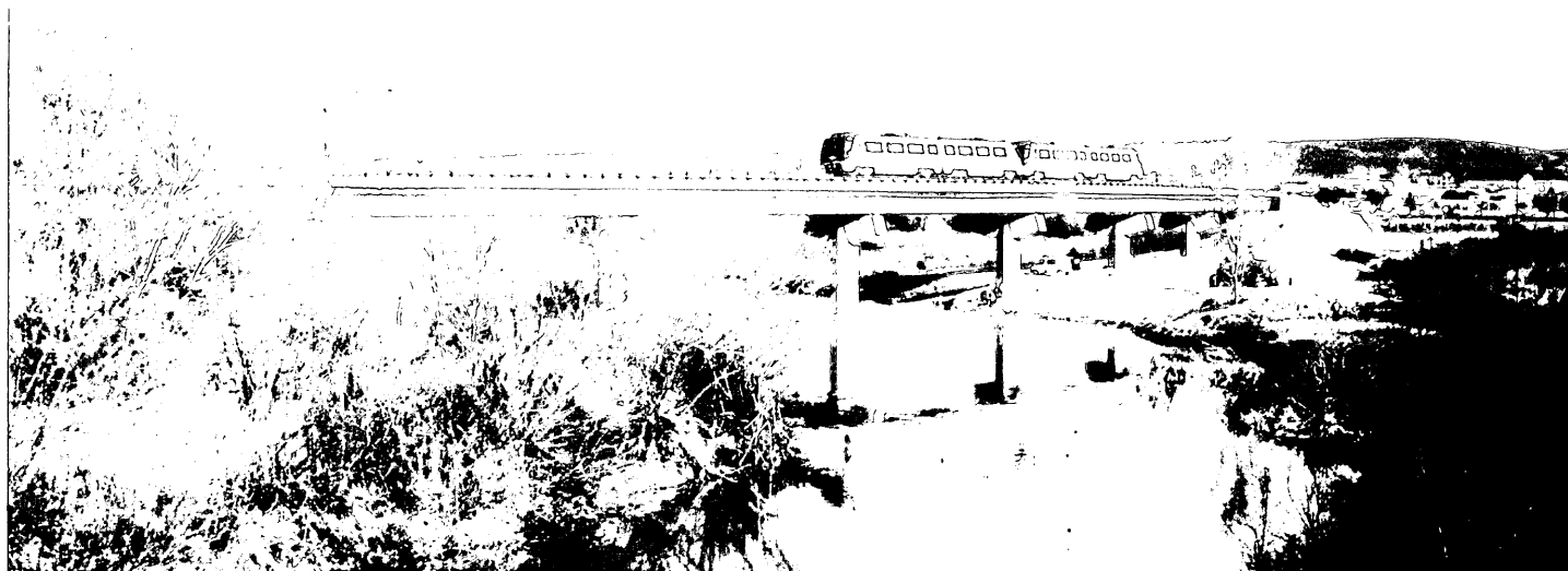
Foto 1. Tren de Arganda. Financiación por concesión administrativa basada en la Ley de Ordenación de los Transportes Terrestres. Abajo, foto 2. Obras de la nueva autopista M-45. Financiación por Pejaje-Sombra.
