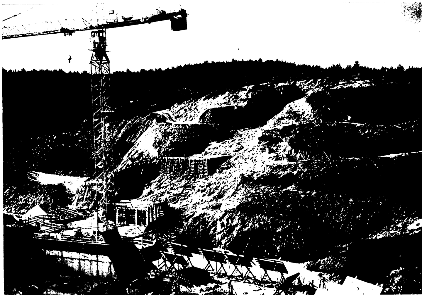
Figura 2. Obra de desvío del río. Abajo, figura 3. Roca de cimentación en la ladera derecha.
