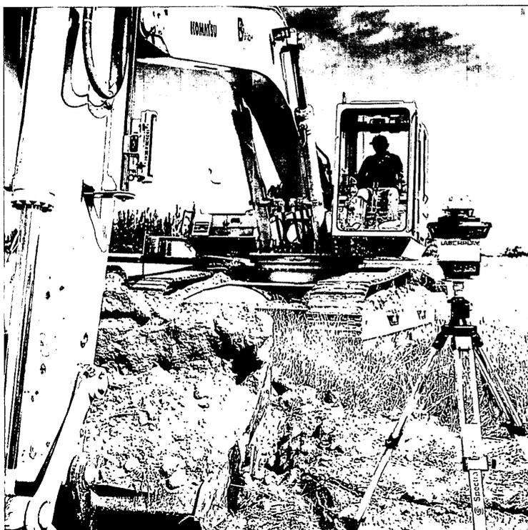
**Figura 5. Emisor y receptor láser sobre excavadora para control automático de pendientes en zanjas.**
