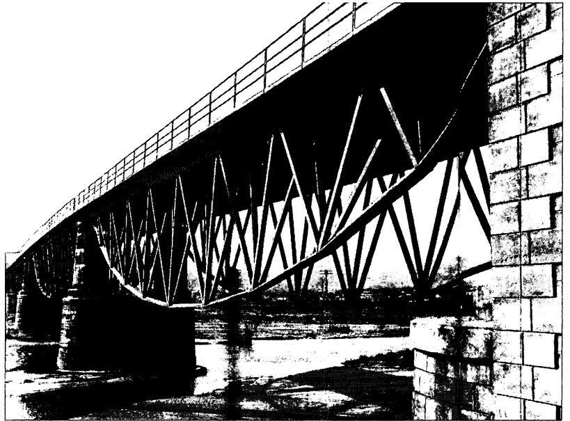
Figura 4. Puente de Tordera. Celosía mixta de canto variable. Torroja (1939) Figure 4. Tordera Bridge. Composite truss of variable depth. Torroja (1939).
