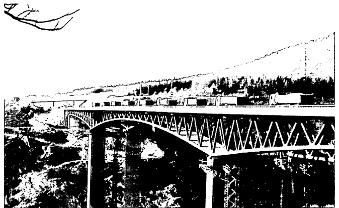
Figura 10. Puente sobre el río Sil/ Figure 10. Bridge over the River Sil.
