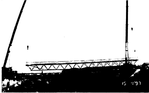
Figura 33. Secuencia de montaje de las celosías del Puente sobre el Barranco de Cavalls, con grúas. Figure 33. Sequence of assembly of the trusses to the Bridge over the Barranco de Cavalls, with assistance of two cranes.
