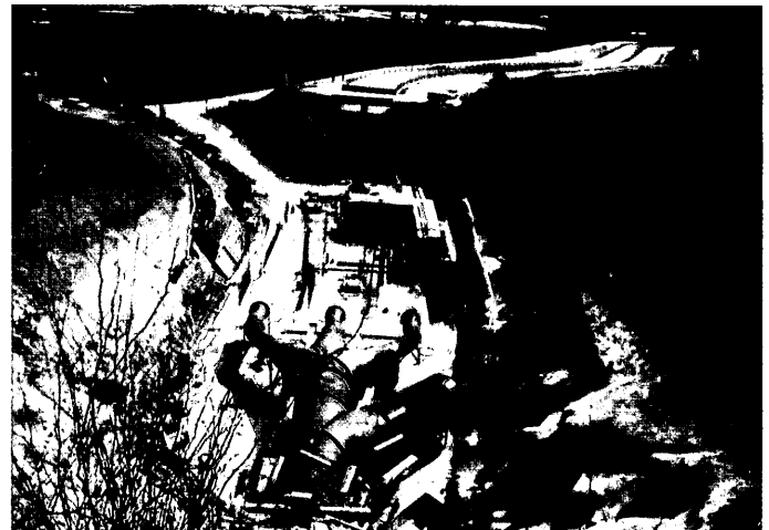
Figura 10. Toma del canal de Navarra. Caseta de válvulas e inicio del mismo..
